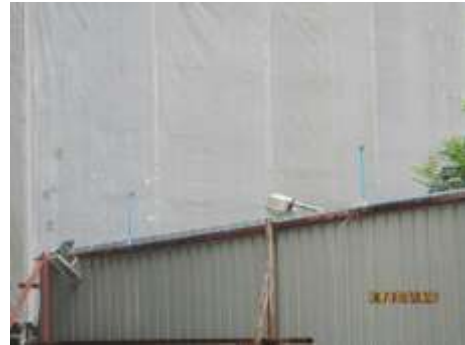
รูปที่ 13 ม่านละอองน้ำบริเวณรั้ว Metel Sheet (ปัจจุบันรื้อถอนแล้ว)
