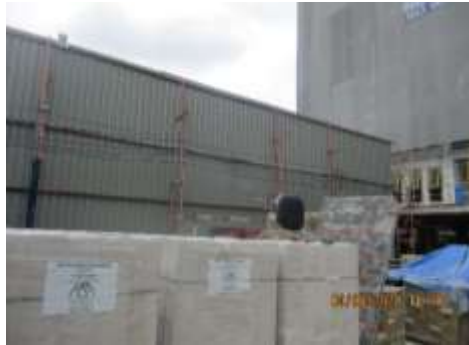
รูปที่ 13 ม่านละอองน้ำบริเวณรั้ว Metel Sheet (ปัจจุบันรื้อถอนแล้ว)
