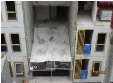
รูปที่ 56 แผงกันวัสดุตกหล่นจากอาคาร (ปัจจุบันรื้อถอนแล้ว)
